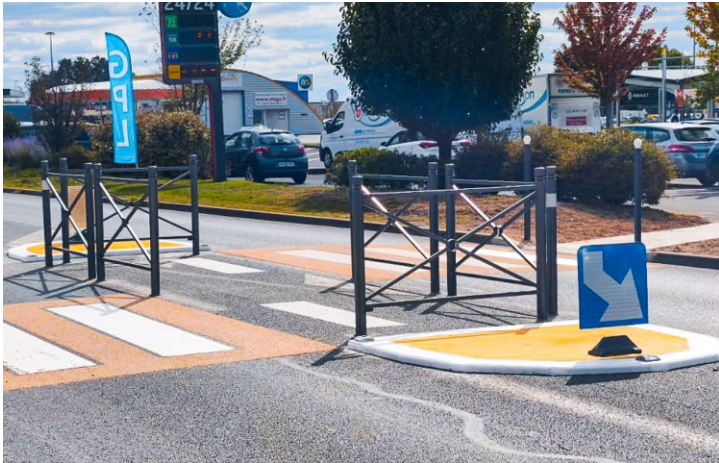
La traversée en baïonnette apporte une sécurité qui n'existait pas encore sur l'axe routier de la rue de Poitiers. (Photo Ville de Mauléon)
