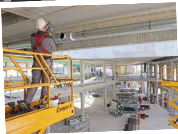
Le gros œuvre est désormais terminé
