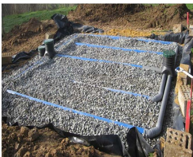
↳ Exemple d'installation photographiée lors d'un contrôle avant remblaiement
