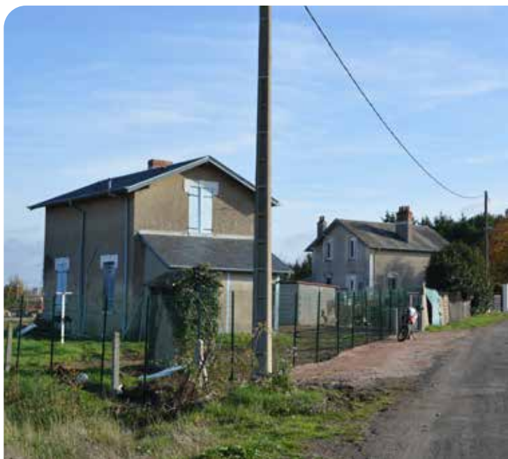
Maisons de gardes-barrières au lieudit le Grands Sablons
