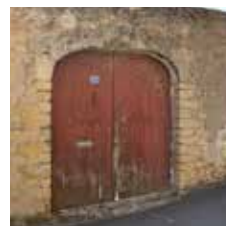
Portail à linteau en arc en anse-de-panier, rue du Mont Alboin
