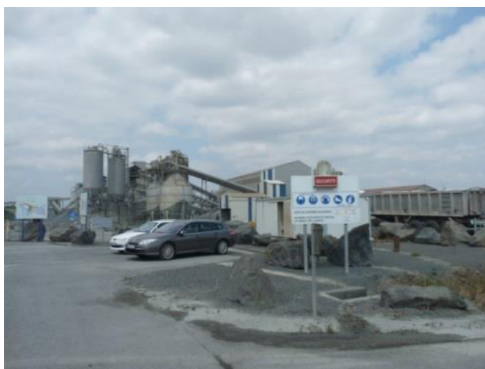
Carrière de granulats de La Noubleau à Saint-Varent (Crédit photo : aura)
