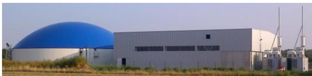
L'usine CAP'TER Méthanisation, implantée à Saint-Varent - Crédit photo : CAP'TER
