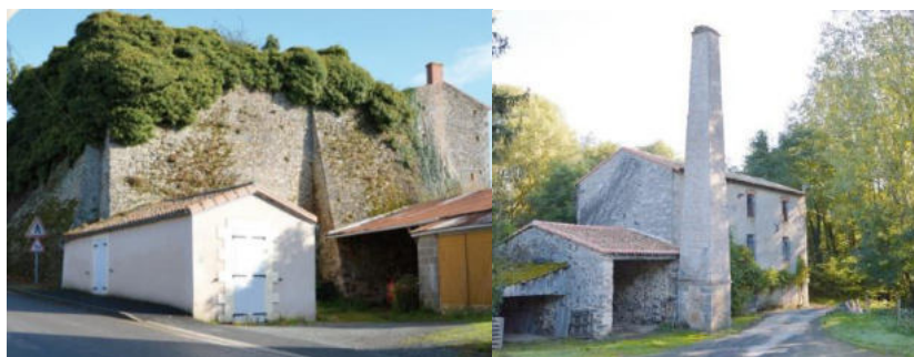
Four à chaux et Moulin de Veillet, tous les deux à Glénay – Saint-Varentais Patrimoine industriel – Service de l'Architecture et des Patrimoines – 2013
