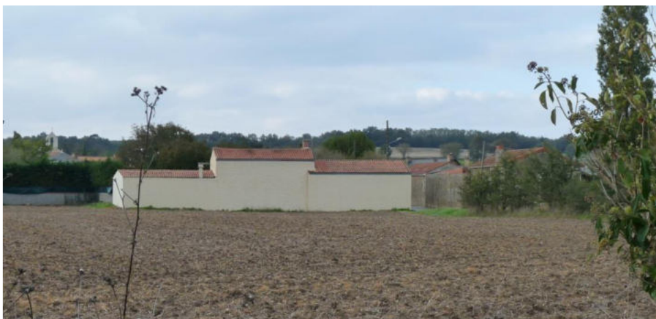
Impact d'un enduit clair en périphérie de bourg, renforcé par l'absence de plantations (Bilazais) – Crédit photo : © aura
