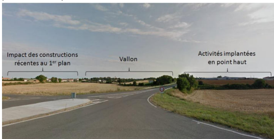
Vue sur la frange sud de St-Jean-de-Thouars depuis la route de Bressuire – Source : Google Maps
