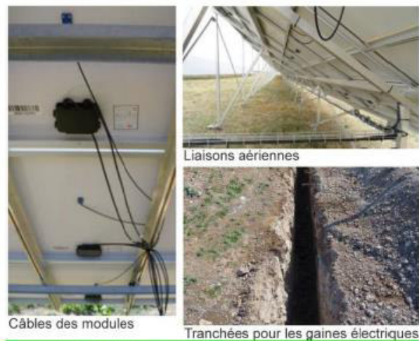
Photographie 9 : Liaisons électriques (Source : ENCIS Environnement)
