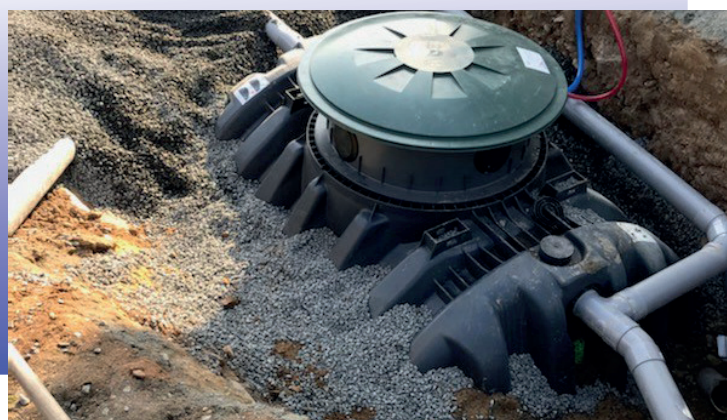
↳ Microstation d'épuration 5 E.H
