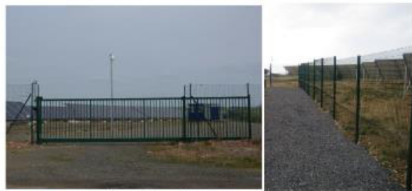
Photographie 11 : Clôture de sécurité et portail d'accès (Source : ENCIS Environnement)
