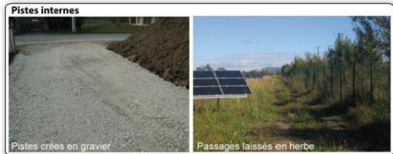
Photographie 10 : Exemple de pistes empierrées et enherbées (Source : ENCIS Environnement)
