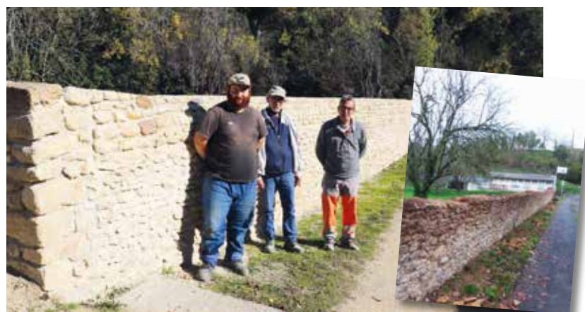
Michel et Quentin ont participé au chantier de rénovation, encadré par Manuel
