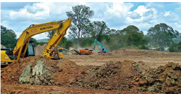
Figure 142. Travaux en zone naturelle. Photo ©S. Nowak. Pixabay
