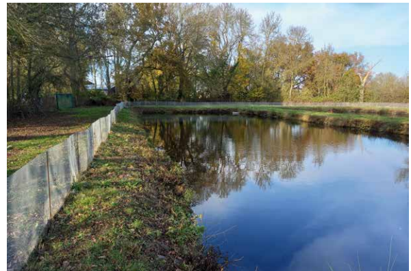
Figure 117. Bassin de lagunage confiné à Bouillé Saint-Paul (79). Photo ©A. Martin
