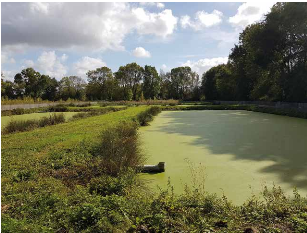
Figure 126. Confinement de la station de lagunage de Bouillé Saint-Paul (79). Photo ©CCT
