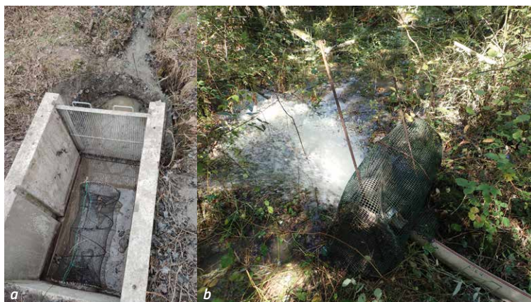
Figure 83a, 83b, 83c, 83d, 83e. Dispositifs de filtration en entrée (zone de pompage) ou sortie des eaux. Photos ©A. Merlet, ©CDPNE.
