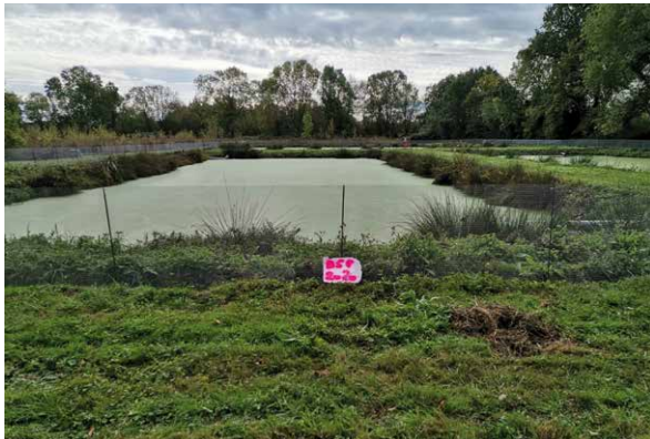
Figure 116. Confinement des 3 bassins de la station d'épuration des eaux usées de Saint-Martin-de-Sanzay (79). Photo ©CCT
