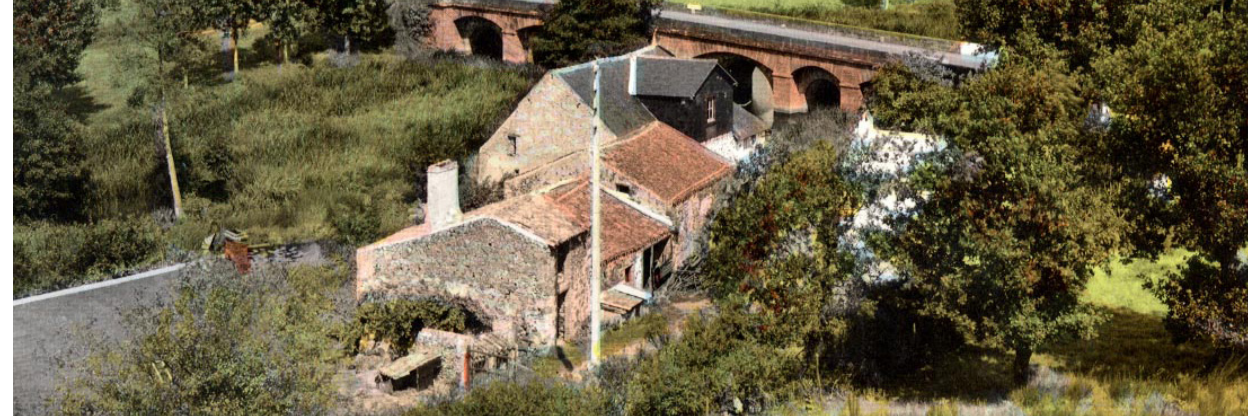
Vue du Moulin Vieux dans les années 1970
