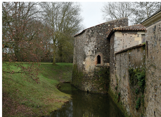
Tour en éperon du château de la Garenne
