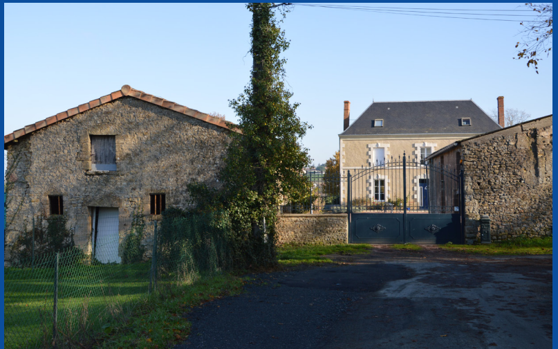
Ferme construite durant le 3 e quart du XIX e siècle, rue du Clos, bourg de Sainte-Radegonde
