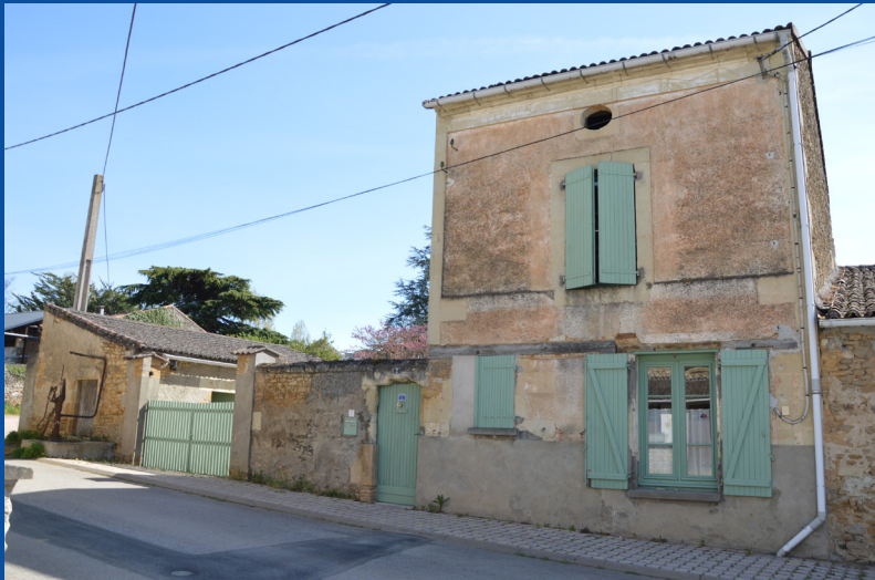
Maison du début du XX e siècle, conservant en rez-de-chaussée le linteau de la devanture d'une ancienne boutique, impasse de la Liberté, Vrines
