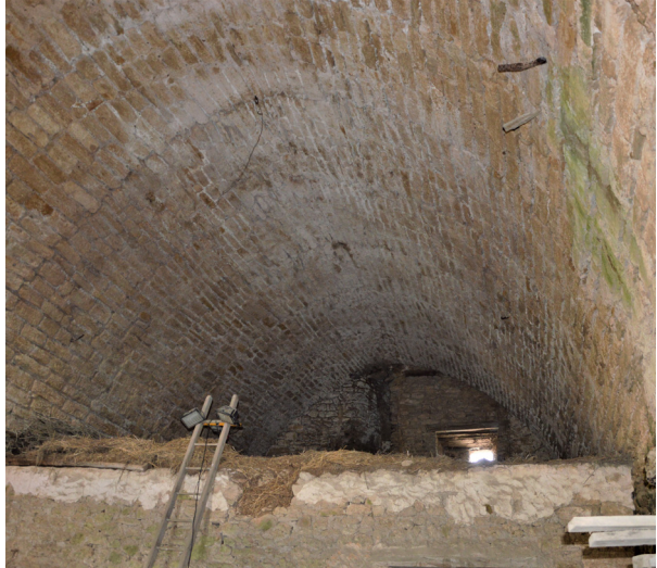
Plafond voûté en berceau de la salle principale de la maison-forte
